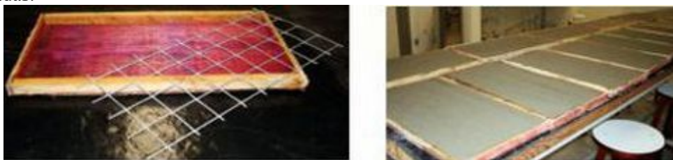
Figura 4 – armadura empregada na confecção dos substratos-padrão e substratos-padrão concretados
