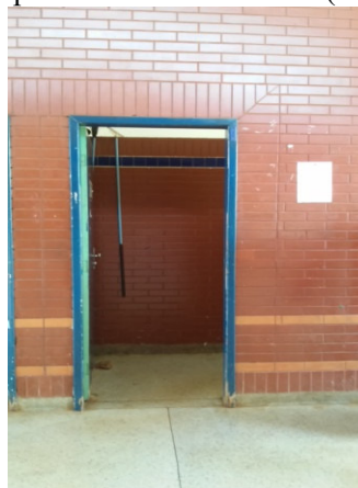
Figura 4: Entrada do banheiro
