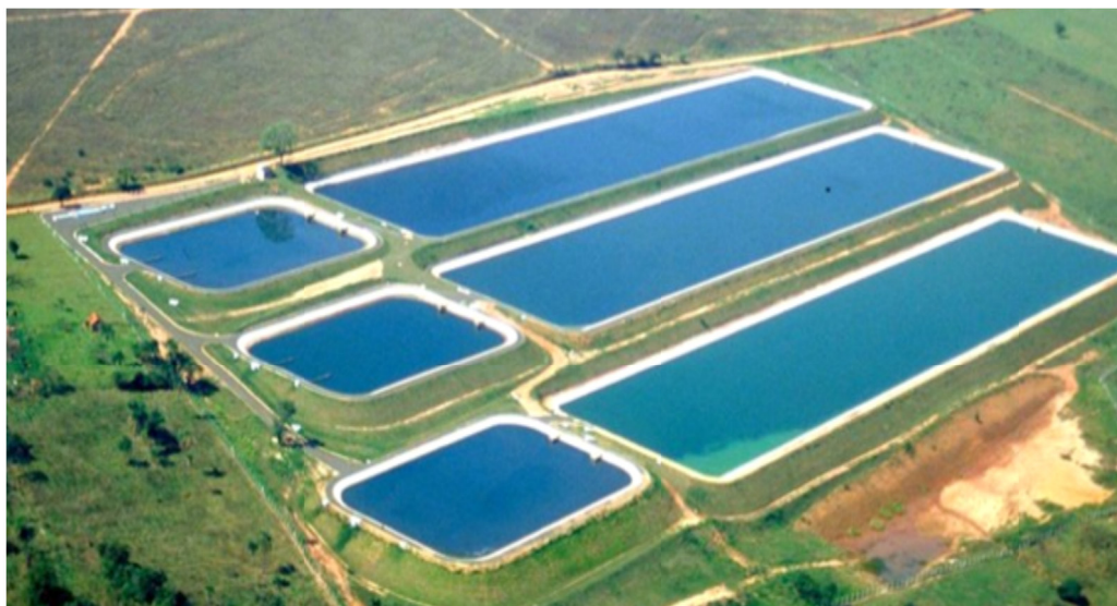
Figura 01. Lagoa de estabilização de Lins São Paulo
