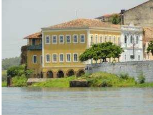
Figura 05 – Construções seculares às margens do Rio São Francisco, no Centro Histórico de Penedo, Alagoas Fonte: MELO, T. Dezembro, 2011.
