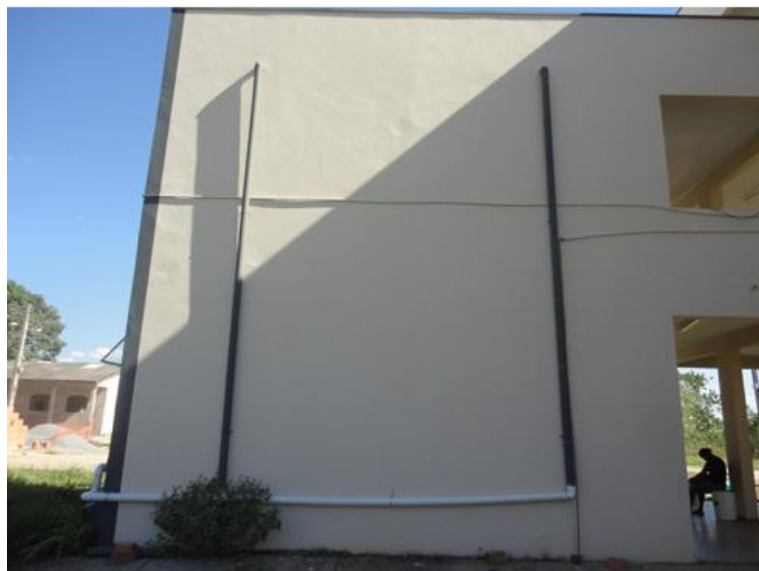
Figura 4 - Vista da canalização pré-existente de cor cinza.
