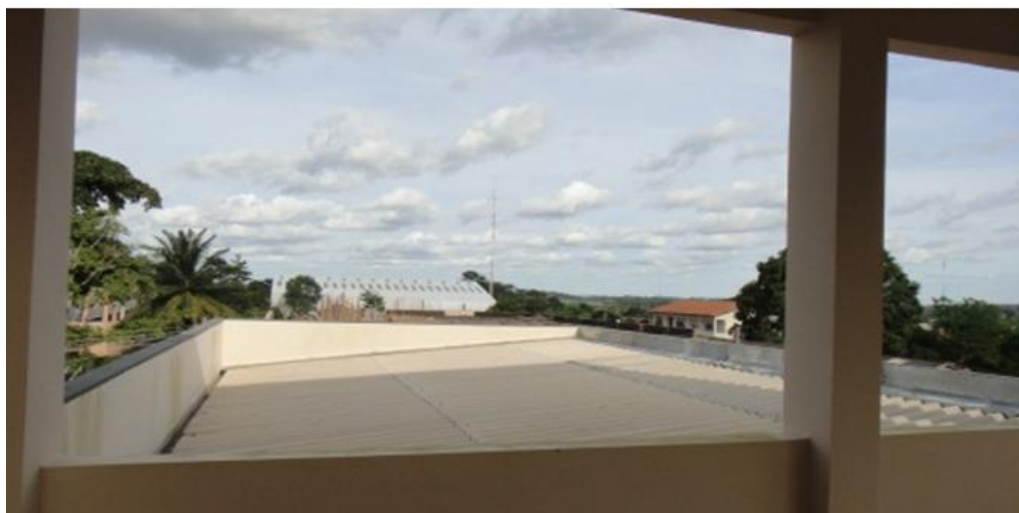
Figura 3 - Telhado do banheiro feminino e masculino do prédio de Engenharia Ambiental.
