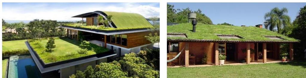
Figura 2 - Coberturas verdes em residências (Fonte: http://arquiteturapaisagismo.blogspot.com.br )
