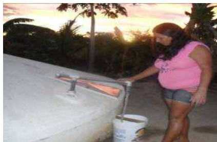
Figura 4: Bomba manual para a retirada da água da cisterna. Fonte: Alves (2012).
