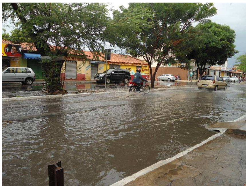
Figura 04 - Lâmina d'água em alguns trechos, em toda a superfície da Avenida Principal do Dirceu. Fonte: Pesquisa Direta , 2012.
