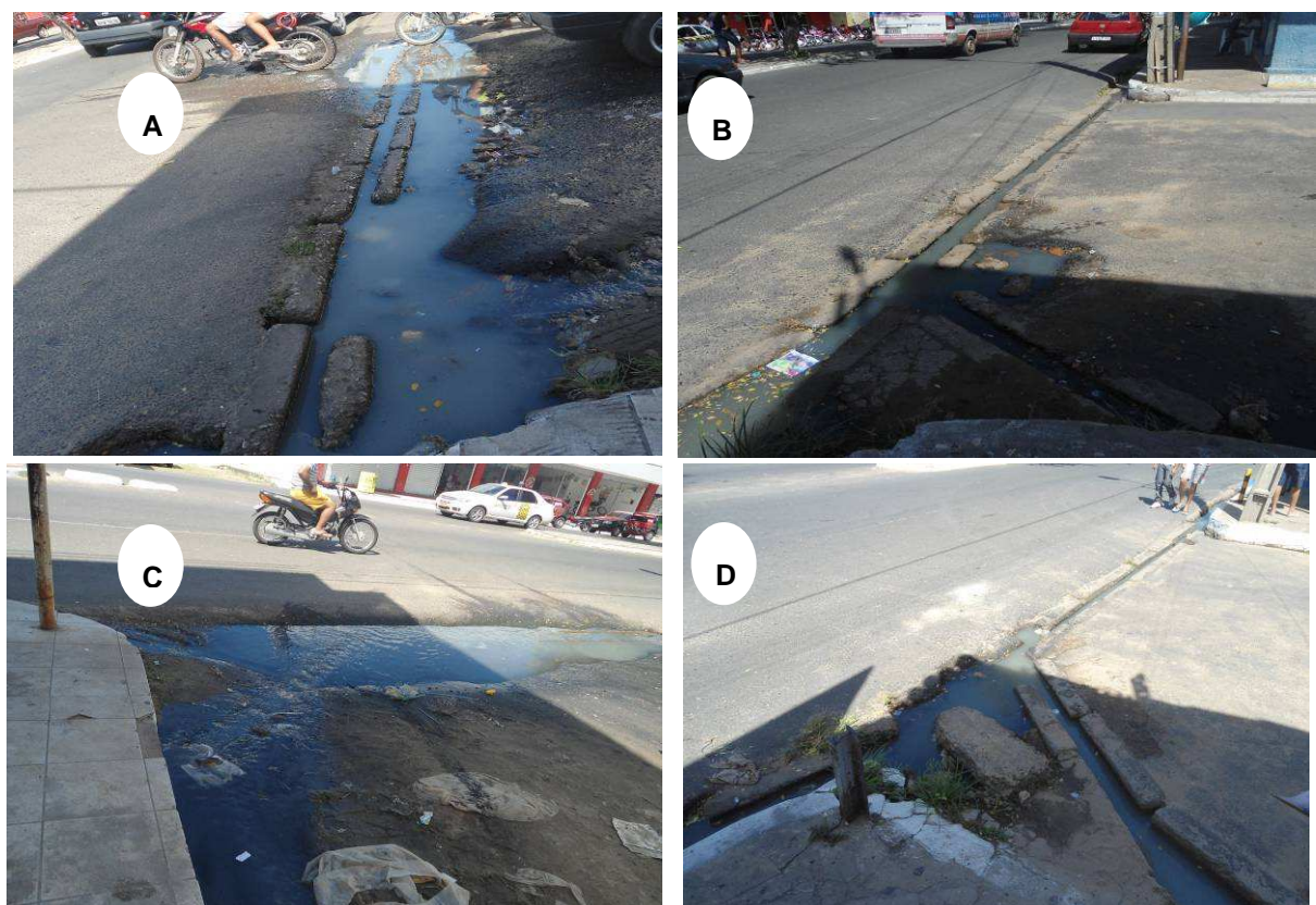
Figura 08 – A), B), C) e D) Sarjetas com manutenção deficiente. Fonte: Pesquisa Direta , 2012.
