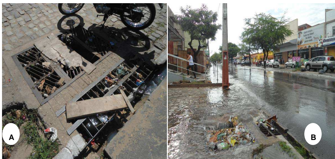
Figura 03 - A) Boca de lobo em período seco. B) Boca de lobo durante precipitação volumosa. Fonte: Pesquisa Direta, 2012.
