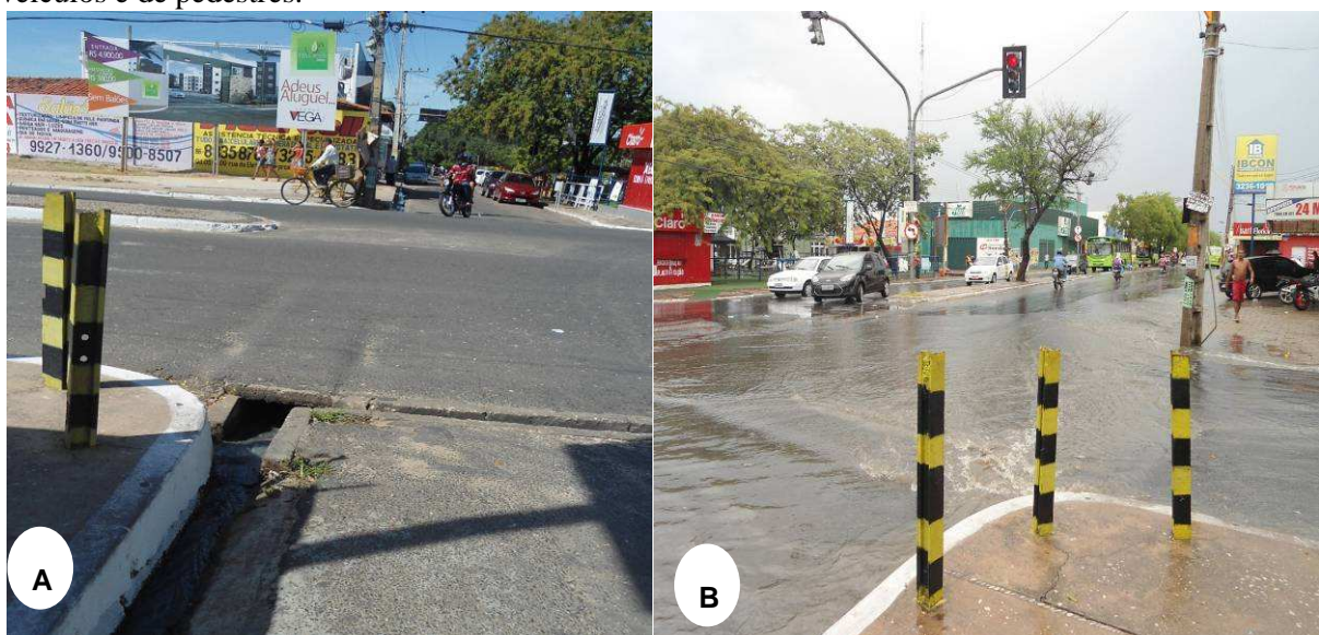
Figura 01 - A) Sarjetão em período seco. B) Sarjetão durante precipitação volumosa. Fonte: Pesquisa Direta , 2012.
