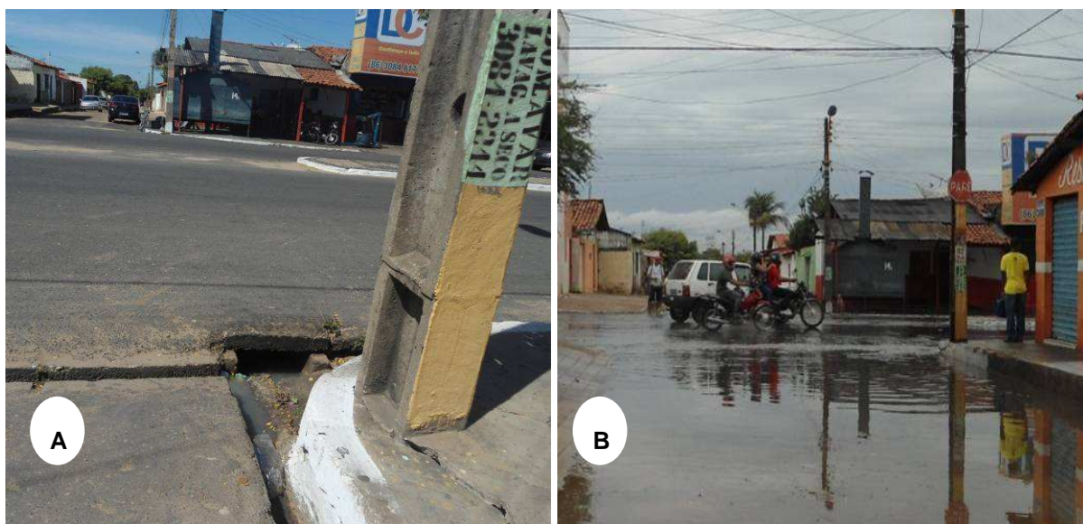
Figura 02 - A) Sarjetão em período seco. B) Sarjetão durante precipitação volumosa. Fonte: Pesquisa Direta, 2012.
