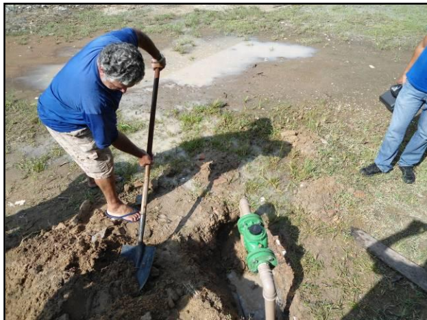
Figura 2: Instalação do hidrômetro na saída do poço artesiano – Campus Boa Vista/RR.
