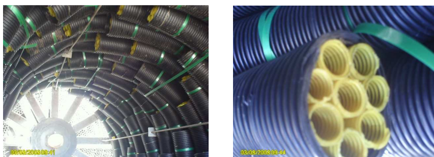
Figura 3 - Detalhe do material suporte dos biodiscos.
