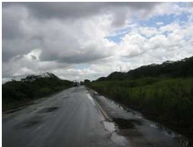
Figura 1 - Condições precárias do pavimento em quase toda a rodovia- BR 304 CE.
