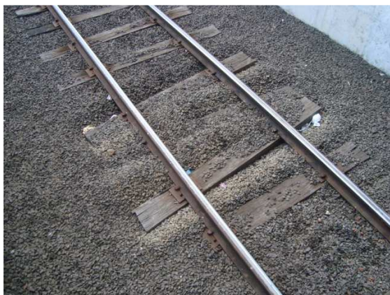
Figura 2 – Dormentes novos já gastos e desalinhados. Fonte: Araújo, 2012.
