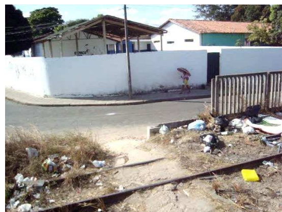
Figura 5 – Travessia irregular e acúmulo de entulho. Fonte: Araújo, 2012
