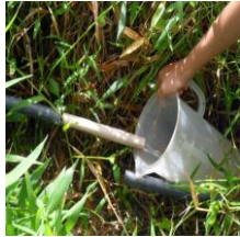
Figura 03 - Tubulação de extravasamento na N.71
