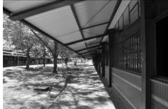
Figura 2: Fachada Lateral – salas de aula e laboratórios.
