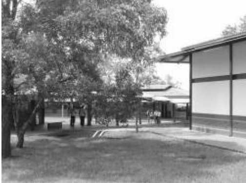
Figura 1: Lateral do bloco do auditório central.
