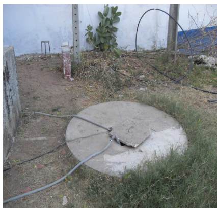
Figura 01: Tanque caixa de passagem.
