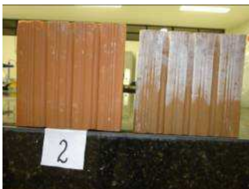
Figura 4 – Eflorescências de cor branca no bloco 2 após o ensaio de eflorescência comparado ao bloco em repouso
